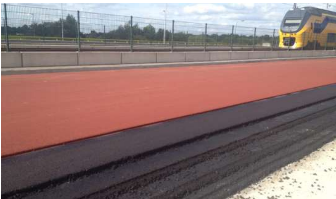
Rysunek 22. Nawierzchnia nowej trasy rowerowej z 5 warstw asfaltu na nowym wiadukcie przez autostradę A2.
