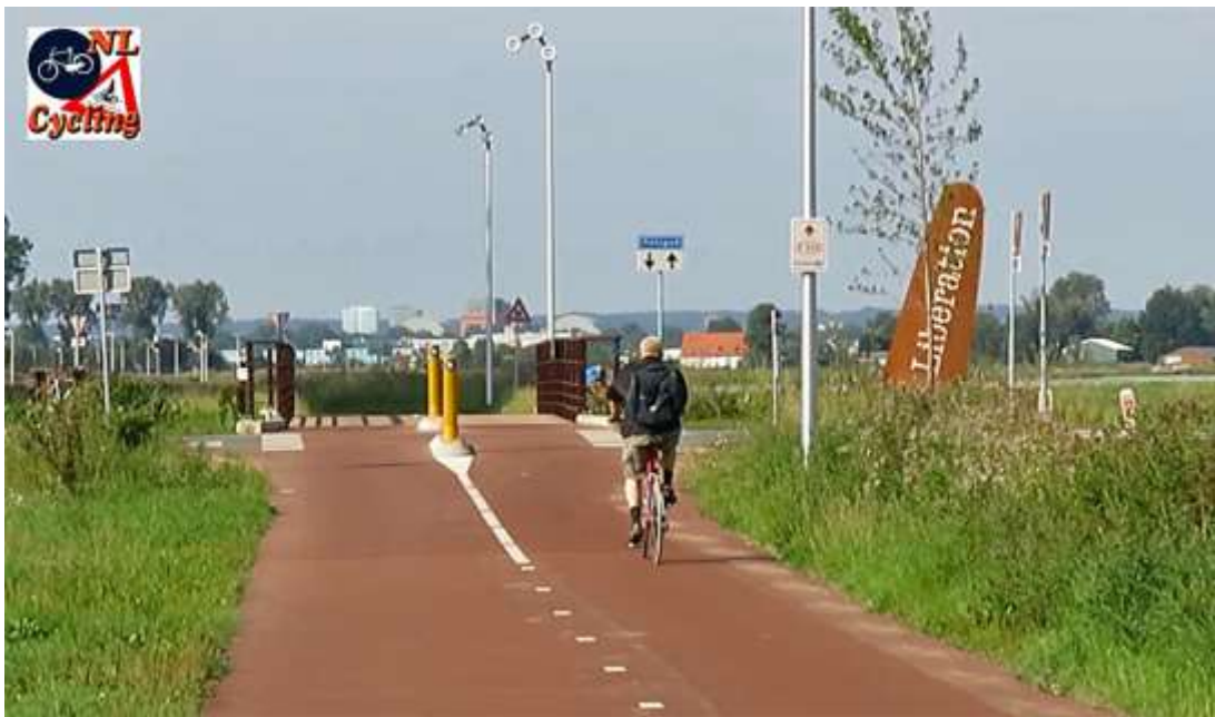
Rysunek 16. Trasa rowerowa w pobliżu Elst. Widoczne oprawy oświetleniowe zaprojektowane specjalnie dla tej trasy również w postaci łańcucha rowerowego. Łącznie umieszczono 134 maszty ze specjalnie zaprojektowanymi światłami ledowymi, w celu dobrego oświetlenia trasy które kosztowały łącznie 190 000 euro.
